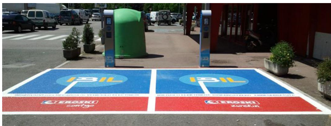
Figura 3: Puntos de recarga en el aparcamiento de un supermercado. Fuente: Ibil.
